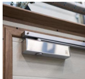
Schienen-Türschließer (Standard).
