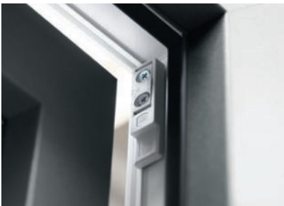
Verdrahteter Reed-Schalter auf der Oberseite
